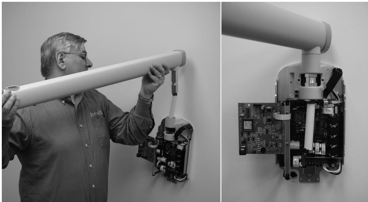
איור 18 התקנת הזרוע האופקית
